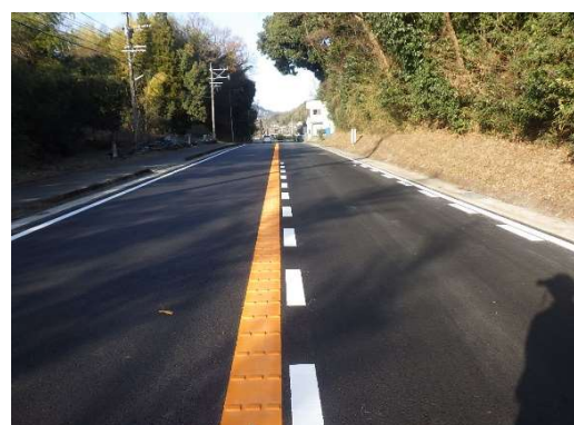
完成 (国道326号) 終点側
