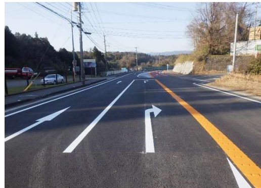
完成 (国道326号) 起点より望む
