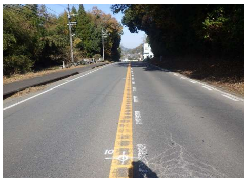
着工前 (国道326号) 終点側
