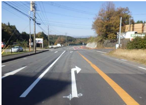
着工前 (国道326号) 起点より望む
