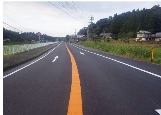
完成 (国道326号) 起点より望む
