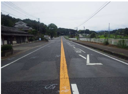
着工前 (国道326号) 終点より望む
