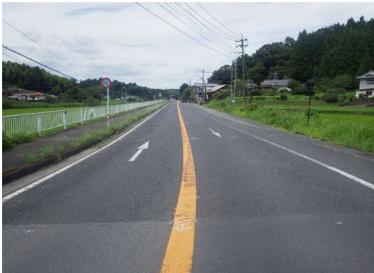
着工前 (国道326号) 起点より望む
