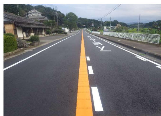
完成 (国道326号) 終点より望む
