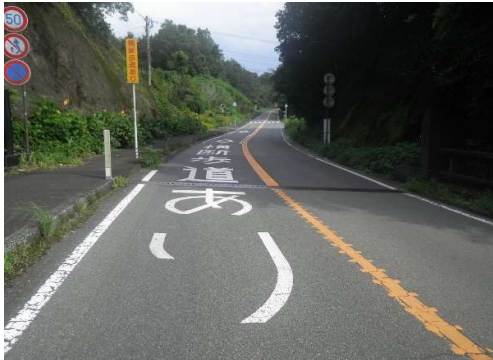
着工前 (国道502号、清川町天神) 起点より望む
