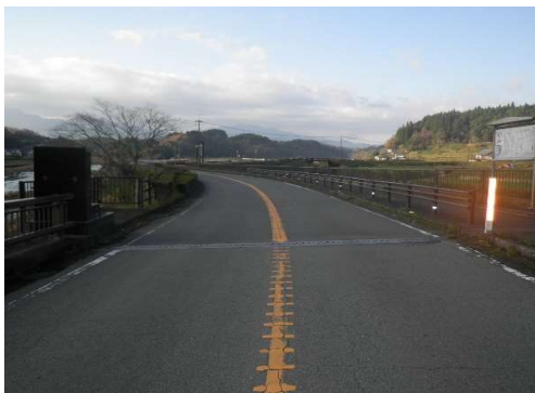
着工前 (国道502号、緒方町野尻) 起点より望む
