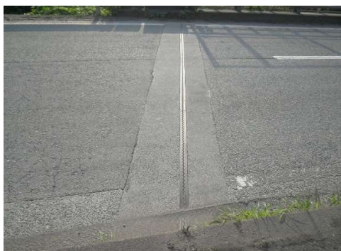
着工前 橋梁伸縮装置
