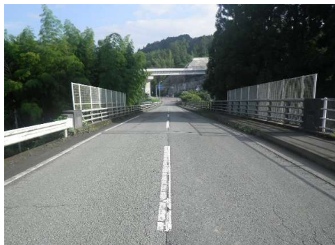
着工前 緒方側より大恩寺交差点側を望む
