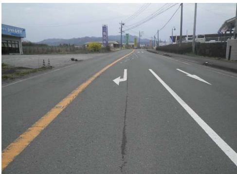
着工前 (国道326号) 終点より望む
