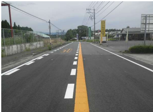
着工前 (国道326号) 起点より望む
