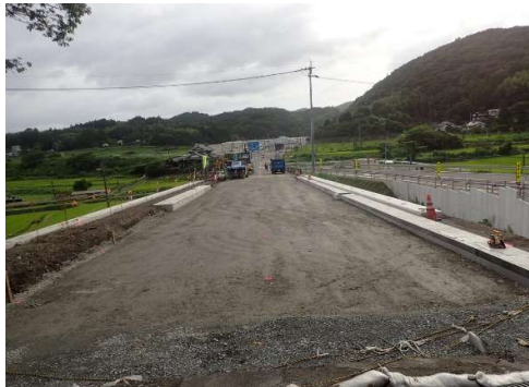
着工前 (旧国道57号線) 犬飼側より望む
