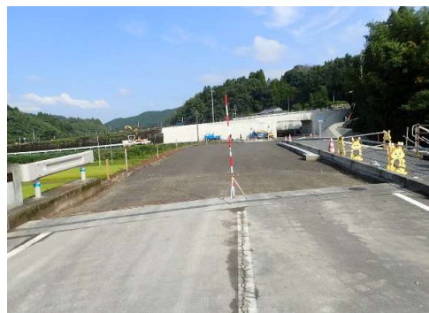
着工前 (県道山内新殿線) 支所側より望む
