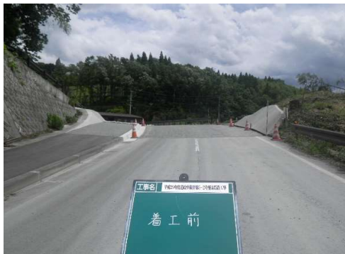
着工前 起点 (池田側) より望む
