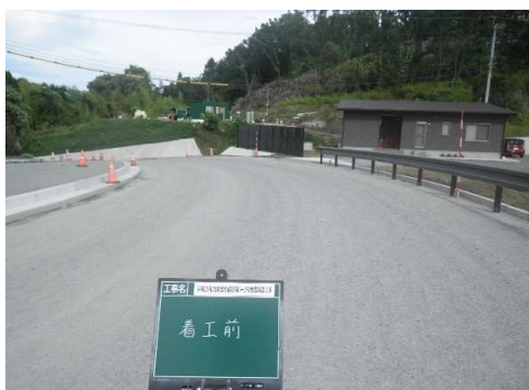
着工前 中間点より終点側 (大原側) を望む
