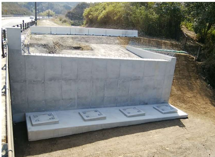
A2橋台工完成
