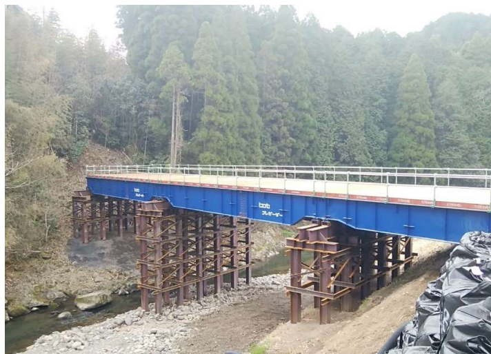
工所用仮栈橋完成
