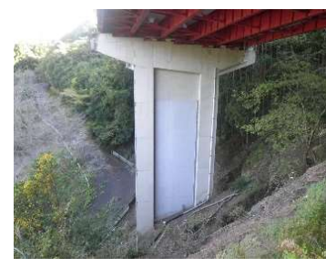
完成（P1橋脚、延岡側より望む）
