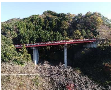
完成（観音新橋、谷側より望む）
