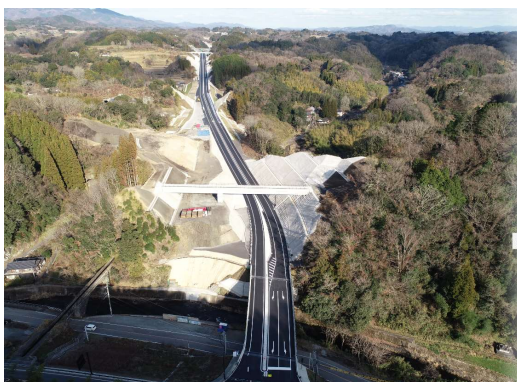
完成 (終点側 全景)
