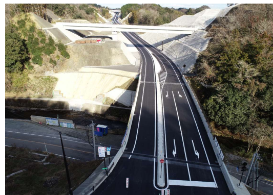
完成 (IC付近を上空より望む)
