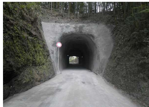
完成（朝地町池田側から望む）
