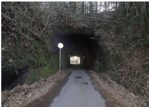
着工前（朝地町池田側から望む）
