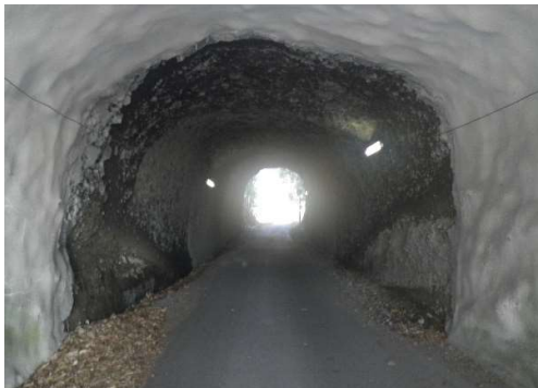
着工前（国道57号側から望む）
