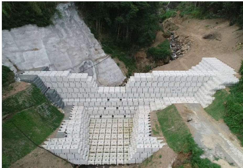
完成(全景) 旧砂防堰堤と新砂防堰堤
